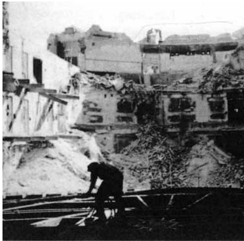
Demolierung der Scala 1959.
